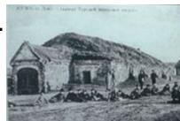
Погреб выстроили из красного кирпича местного производства с применением блоков из ракушечника для устройства фундамента. Белокаменные блоки использовали и как облицовочный материал. Для возведения полукруглого свода внутри были устроены подмостки и кружала.
