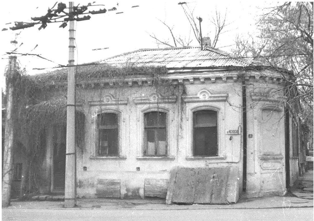
Парадный южный фасад литеры А выявленного объекта культурного наследия. Фото 1993 года.
