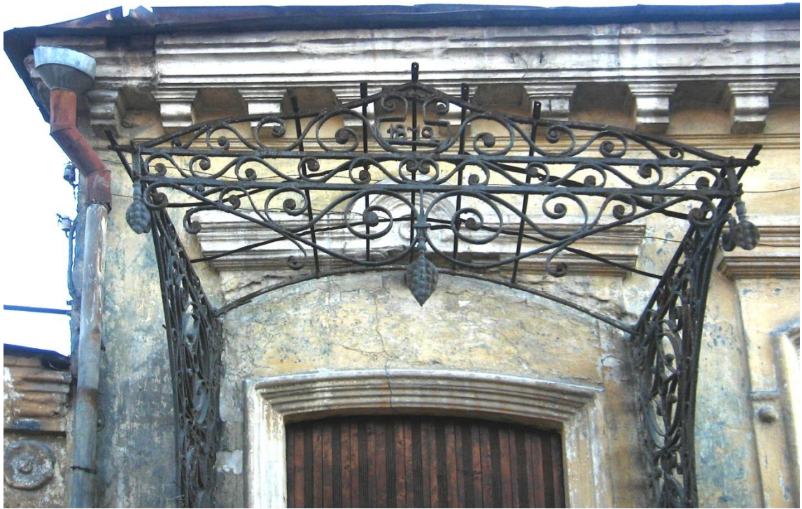
Козырек над главным входом на южном фасаде литера А домовладения по адресу: Ростовская область, г. Ростов-на-Дону, ул. Московская, 41/27, пер. Островского. Архивное фото 07.07.2010 г.
