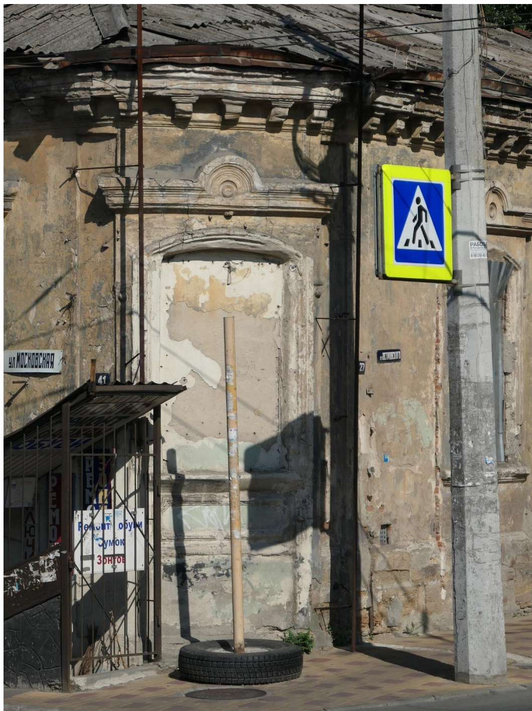
8. Ростовская область, городской округ город Ростов-на-Дону, город Ростов-на-Дону, ул. Московская, дом 41/27. Угловая раскреповка между парадными южным и восточным фасадами литера А, входящего в состав Объекта. Фото 04.07.2023 г.
