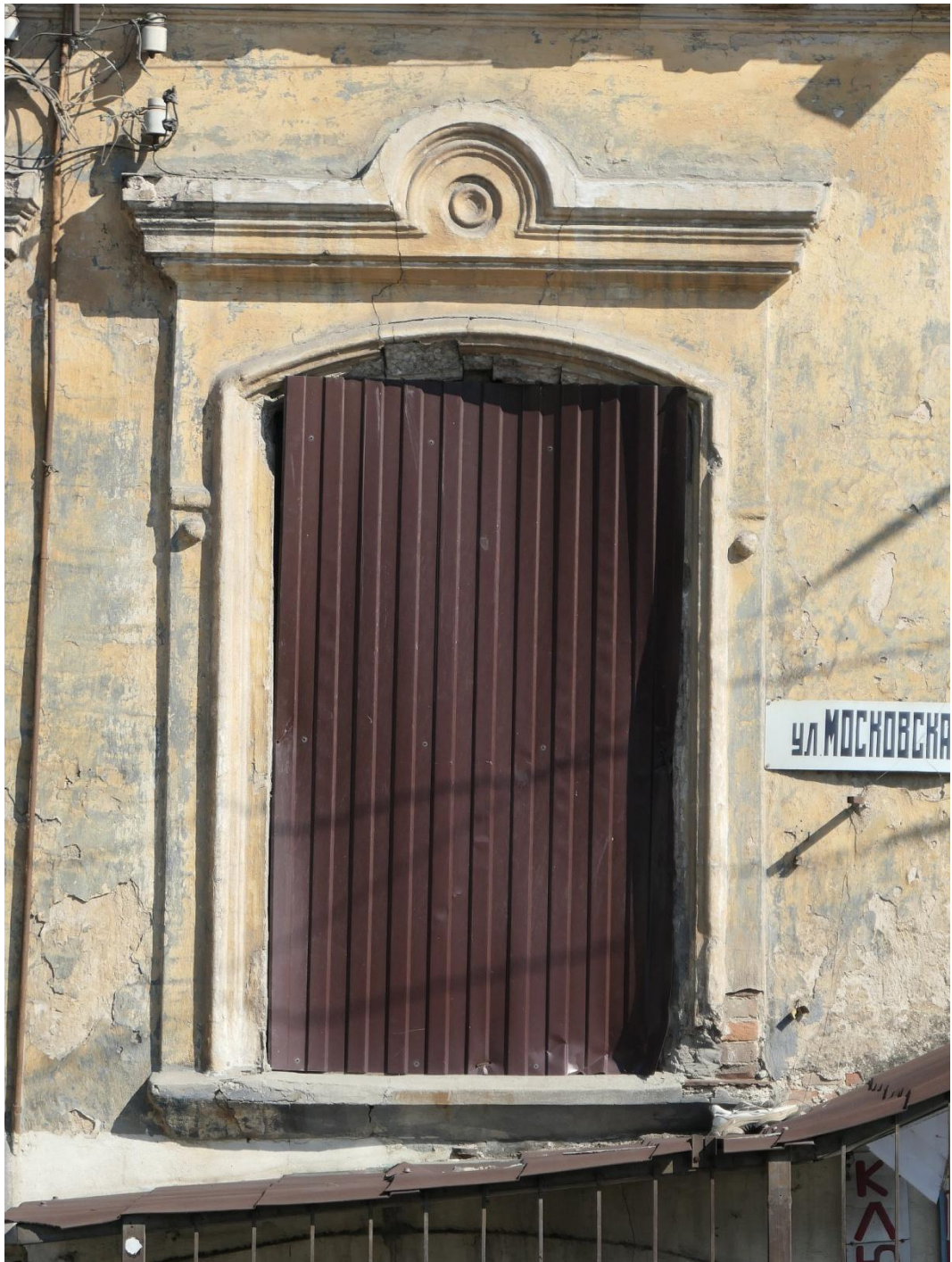
7. Ростовская область, городской округ город Ростов-на-Дону, город Ростов-на-Дону, ул. Московская, дом 41/27. Окно на парадном южном фасаде литера А, входящего в состав Объекта. Фото 04.07.2023 г.
