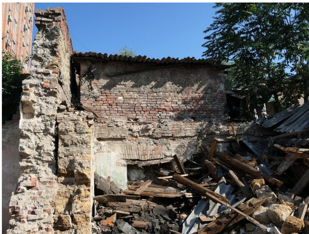
Вид строения литер Б1 домовладения по адресу: Ростовская область, г. Ростов-на-Дону, ул. Московская, 41/27, пер. Островского с юга. Фото 04.07.2023 г.
