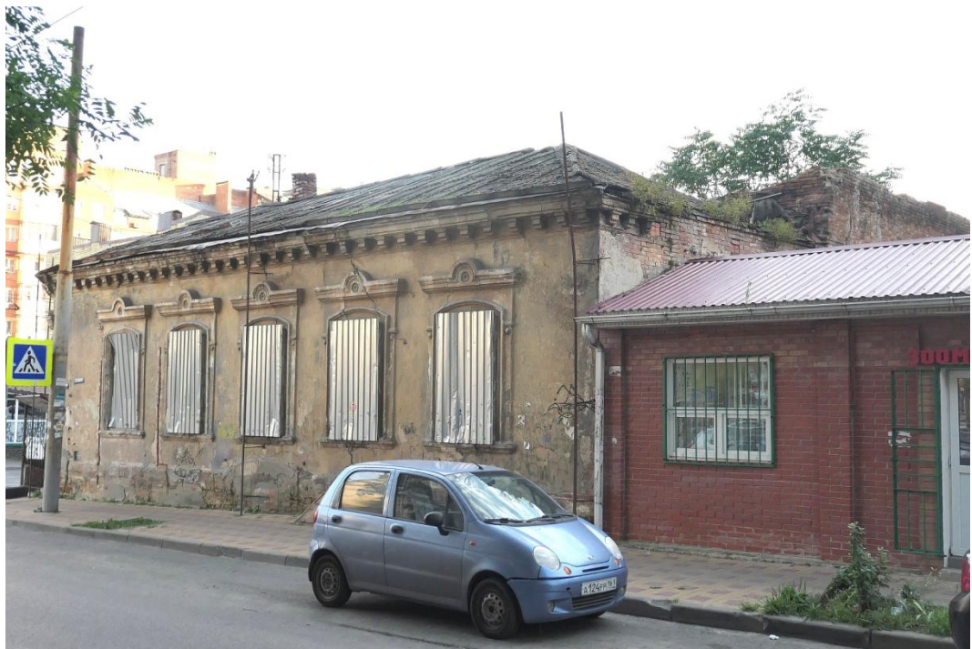
3. Ростовская область, городской округ город Ростов-на-Дону, город Ростов-на-Дону, ул. Московская, дом 41/27. Общий вид Объекта с северо-северо-востока. Фото 27.06.2023 г.
