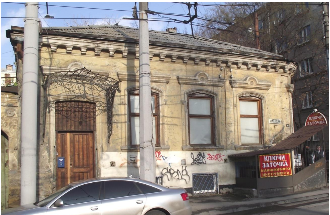
Парадный южный фасад литеры А выявленного объекта культурного наследия. Фото 2010 года.
